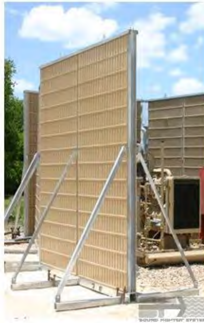
Fíor 9.4: Sampla de Phíosa de Bhacainn Torainn atá Feistithe go Sealadach
